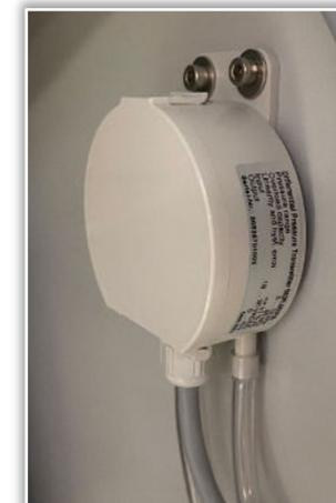
Überwachung Filterzustand über Filter-Differenzdruck
